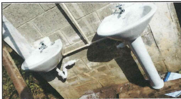
Foto 3: Instalación de dos lavamanos con pedestal que beneficiara a la comunidad educativa.
