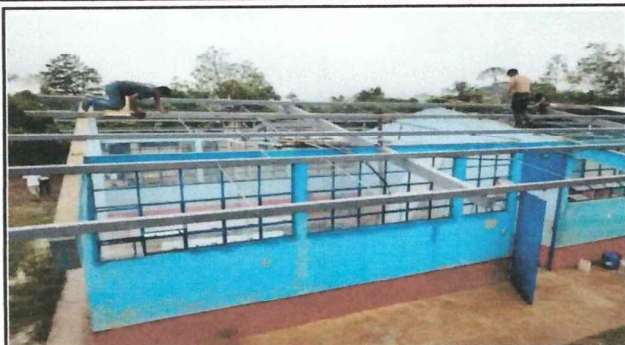
Foto 1: Dando el mantenimiento de la costanera, para posterior colocar las laminas para el menoramientos del INBTS Sesajala Las Pacayas.
