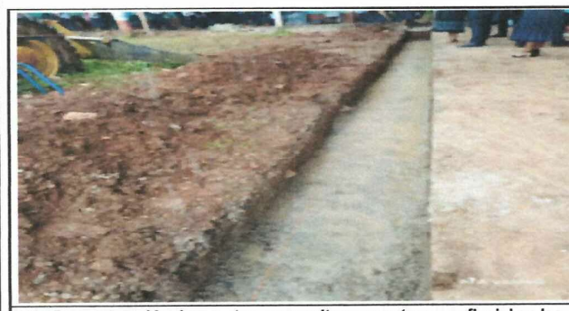
Foto 5: construcción de cunetas, para evitar que entre agua fluvial en las aulas del Instituto Nacional de educacion Básica de Telesecundaria, Sesajal Las Pacayas.
