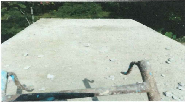
Foto 2: Se finalizo con la fundación de la terraza, del servicio sanitario, donde se instalara el tinaco.
