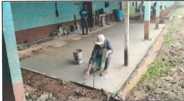
Foto 4: Realización del entortado, frente tres aulas de primaria y donde funciona CEDODII, pero que tambien es utilizada por los jovenes del INBTS de Telesecundaria, Aldea Sesajal las Pacayas.
